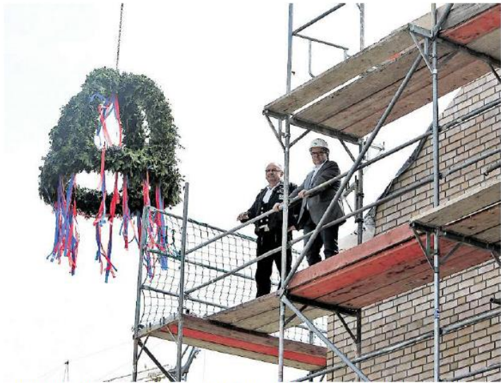
Richtfest: Der Rohbau des ersten Hauses im Gamsener Wohnpark Lindenhof ist fertiggestellt. Das feierte GWG-Geschäftsführer Andreas Otto (r.) mit zahlreichen Gästen.
